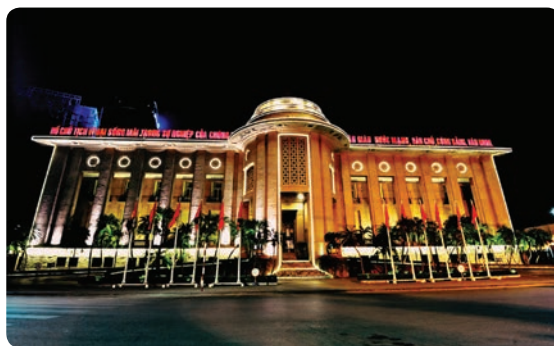
Hình 4. Ngân hàng Nhà nước Việt Nam (quận Hoàn Kiếm)
